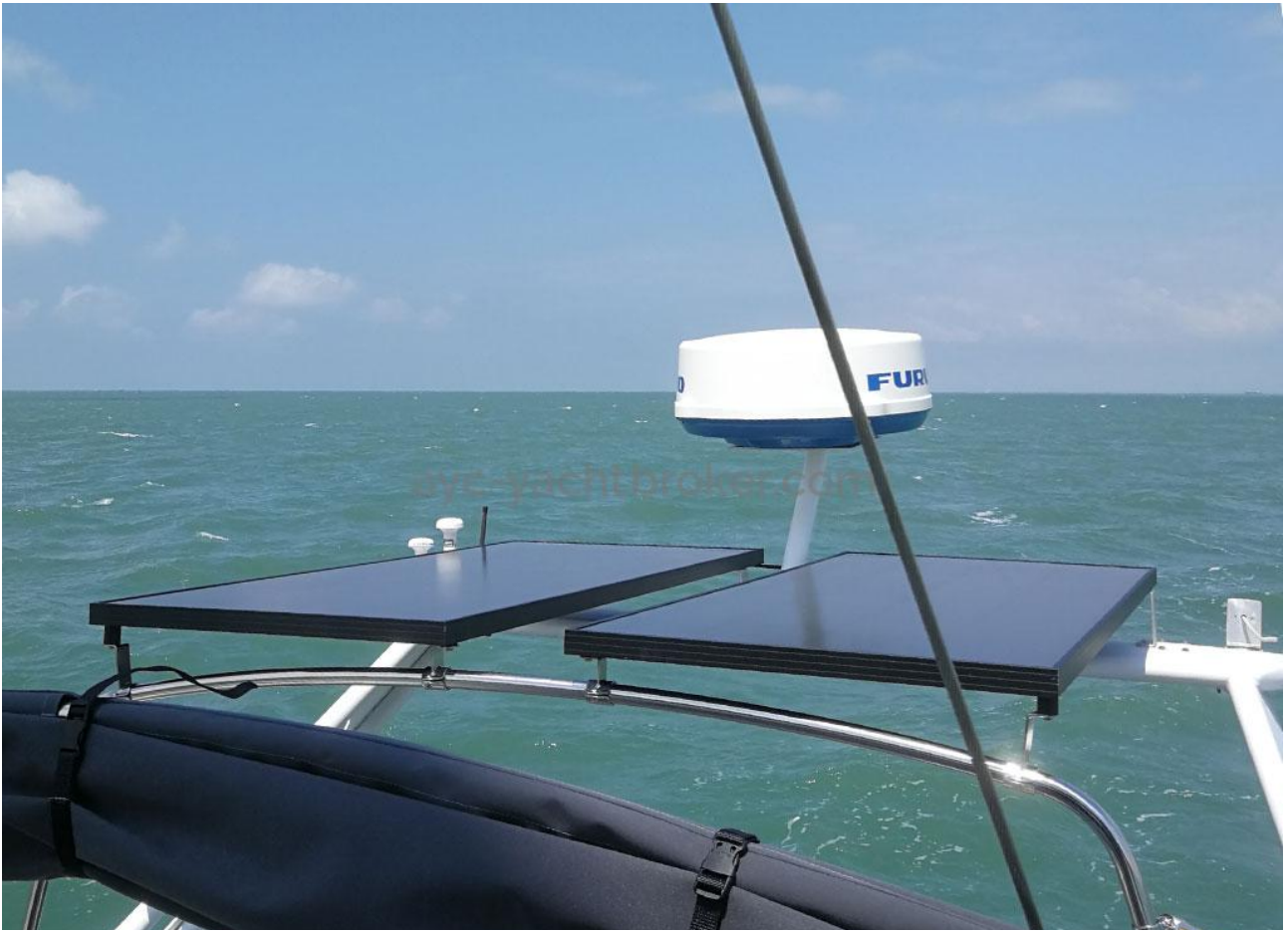
OVNI 47 - Panneaux solaires sur portique rapporté
